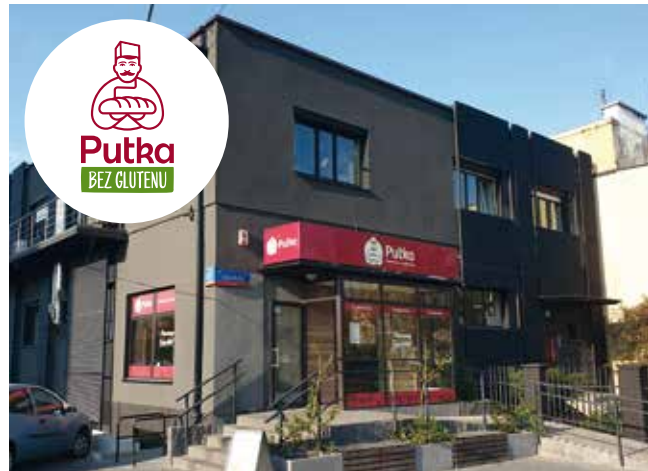
Budynek piekarni przy ul. Tarnowieckiej 41
